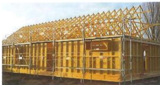
Une ossature bois n'impose pas nécessairement de bardage bois, un enduit est aussi possible
