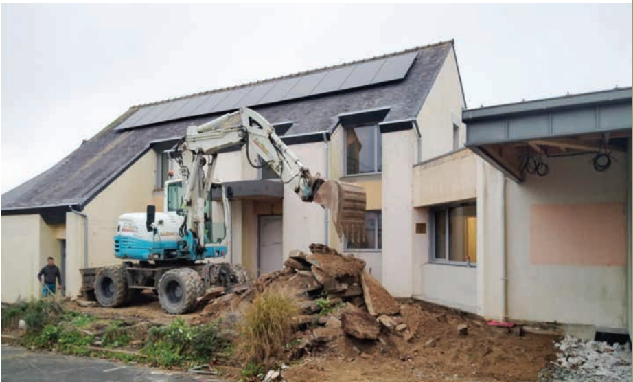
Démolition du parvis de la mairie
