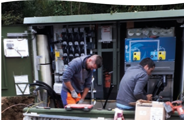
▲ Intervention du SDEF sur le réseau électrique
